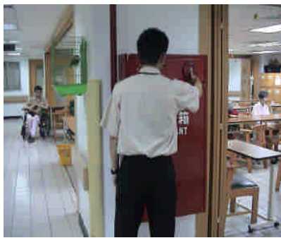
一、按消防警鈴接獲現場火災確認人員呼叫。
